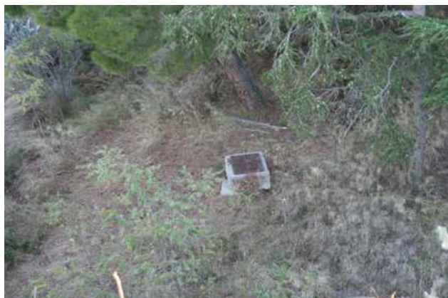
Photographie 17 : Une des cheminées du tunnel située derrière le Mas de Les Coves
