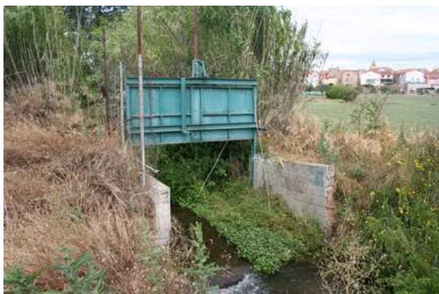
Photographie 14: Une vanne avec la prolifération de mousse
